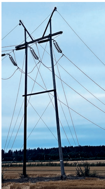
Lammaisten Energia uudistaa Harjavan ja Euran välistä voimajohtoa nyt kuuden kilometrin matkalta.
