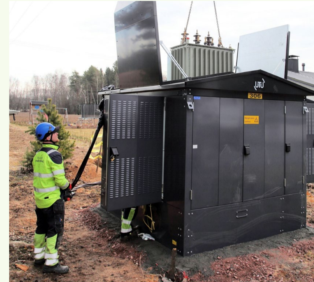
Uuden kauko-ohjattavan erotinaseman ja muuntamon asennus käynnissä.
